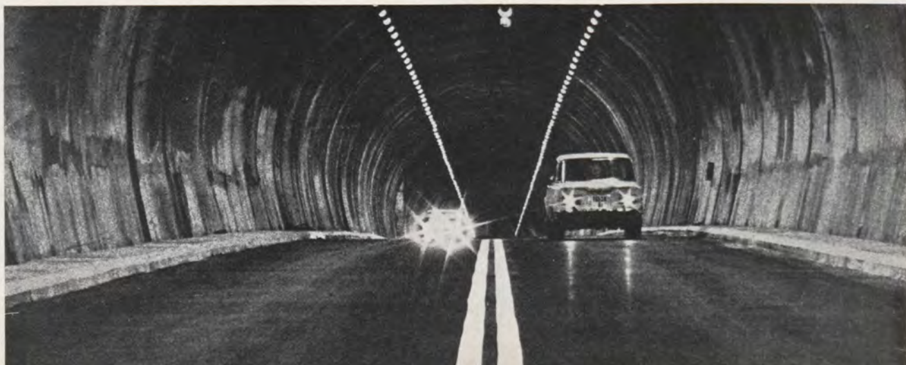
L'interno della galleria che con i suoi 12 chilometri circa, attraversa tutto il massiccio del Monte Bianco.
